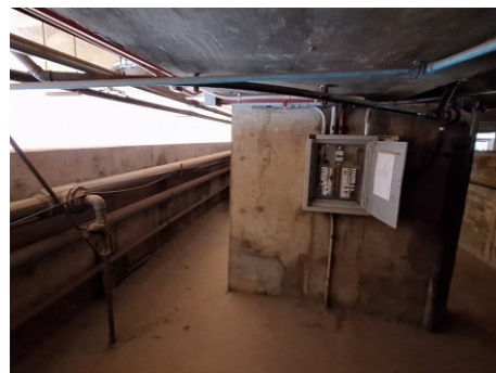
Detalhe de quadro de distribuição sem proteção do barramento e Tirante de suporte de tubulações parcialmente solto
