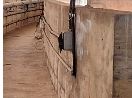
Detalhe de caixas de passagem sem tampa ou tampa solta
