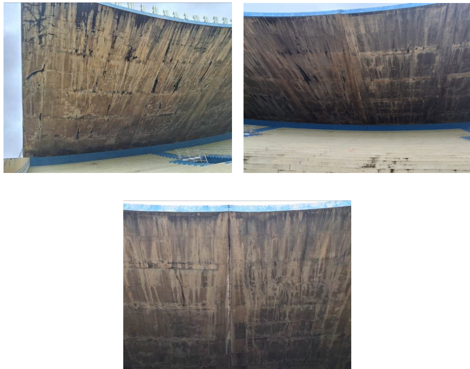
Vista da condição típica das coberturas
