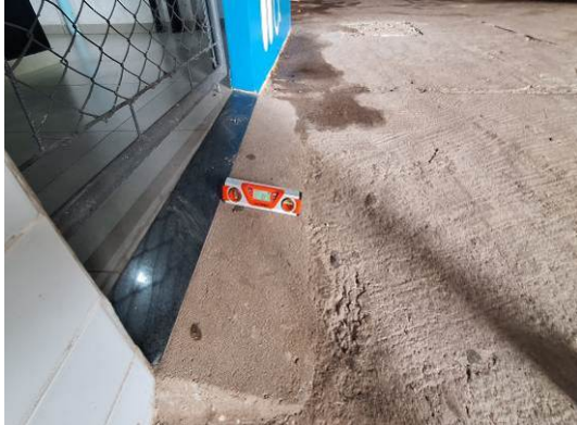
Detalhe dos desníveis e rampas e acabamento de pisos fora de conformidade técnica
