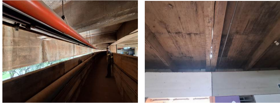
Detalhe da condição típica das juntas estruturais
