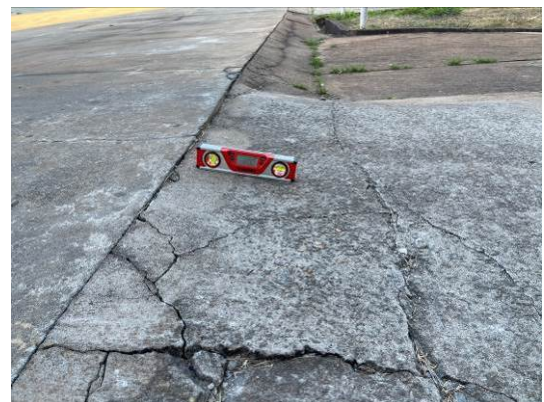
Vista da plataforma para P.C.R e acesso fora de conformidade técnica
