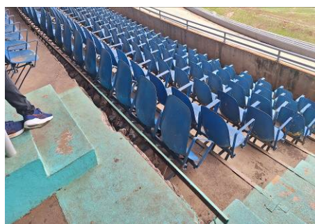
Detalhes do estado geral das cadeiras com falhas de fixação, unidades faltando e pintura em final de vida útil
