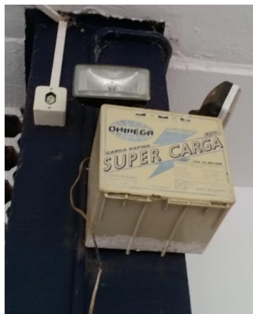
Bloco autônomo de emergência – Corredor.
