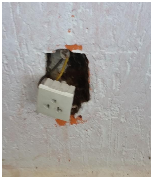
Padrão antigo de tomada. Tomada sem espelho. Tomada solta. - Sala de imprensa.
