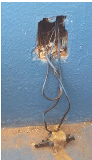
Caixa p/Tomada sem espelho. Tomada solta – Sala da imprensa.
