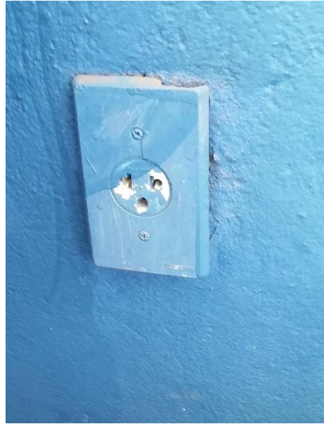
Padrão de tomada antigo. Tomada pintada. – Sala da imprensa..
