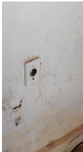
Tomada – Lanchonete/ Escada 01
