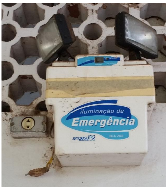
Bloco autônomo de emergência – Corredor.
