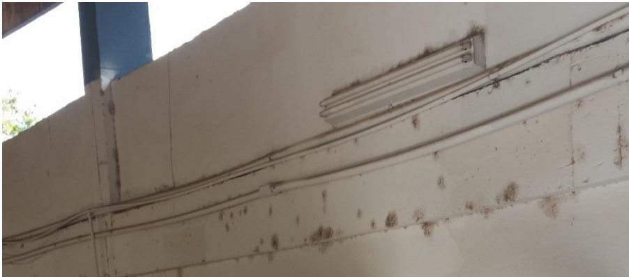
Eletroduto aparente – Corredor/ Juizado
