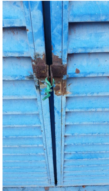
Porta Cabine Elétrica – Torre 3
