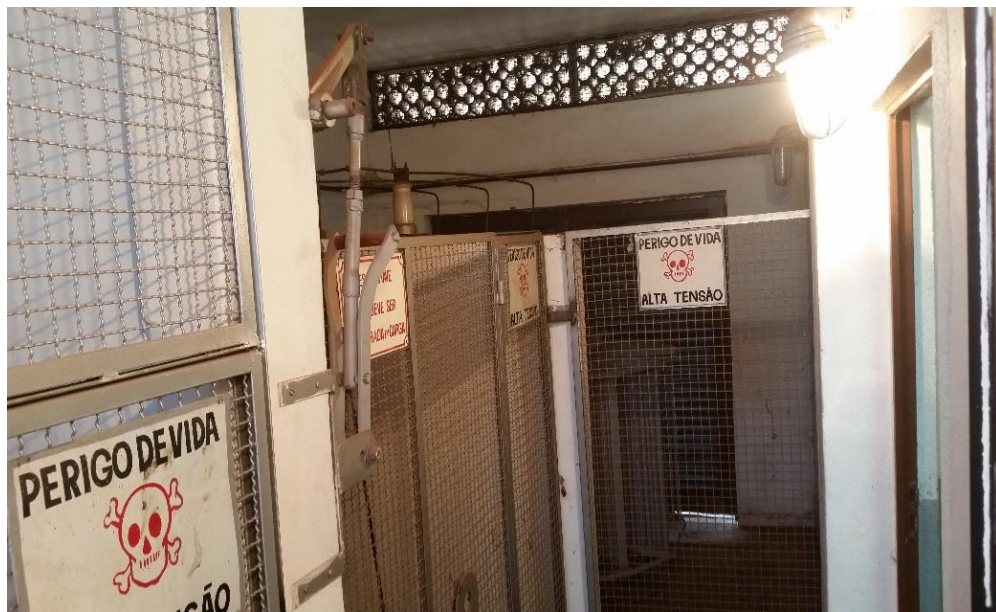
Edifício da Subestação
