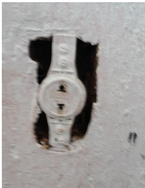
Tomada sem espelho e coberta de tinta. Sala de imprensa.
