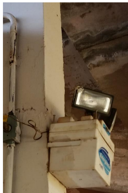
Bloco autônomo de emergência – Corredor.
