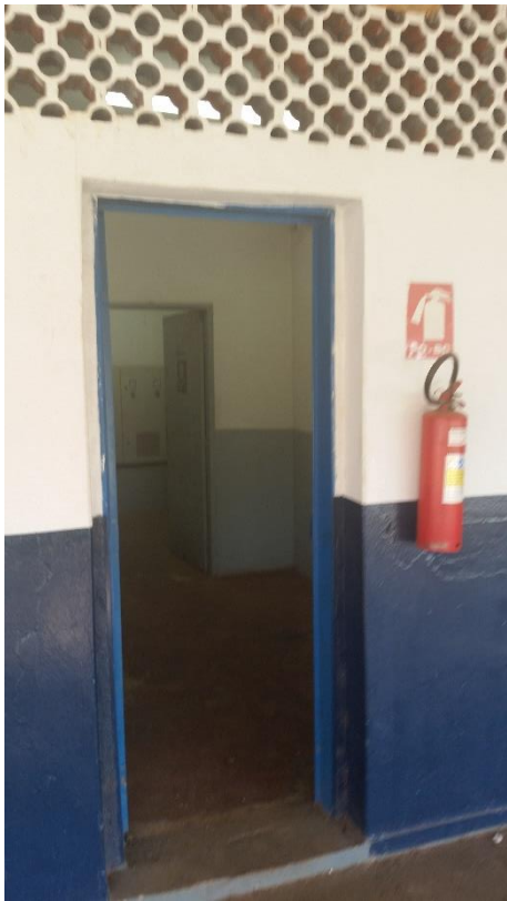
Entrada – Sala Técnica
