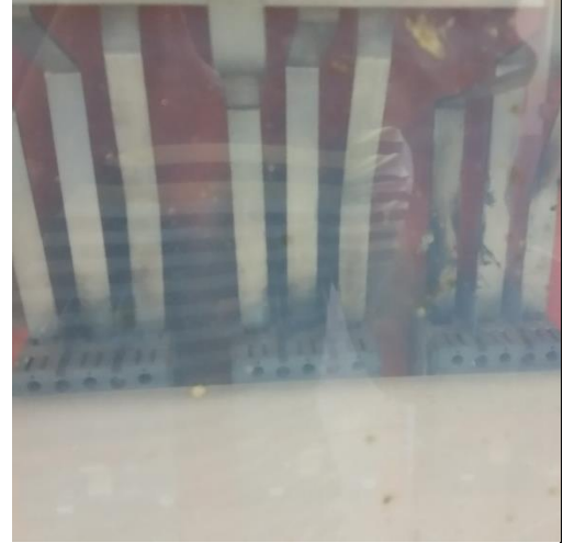
Barramentos – QDL-Campo (Barras ennegrecidas)
