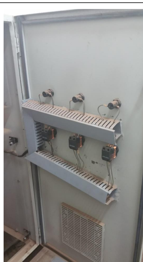
QDL-Campo - Porta – Parte interna
