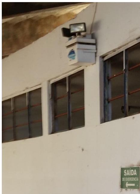
Bloco autônomo de emergência – Corredor.
