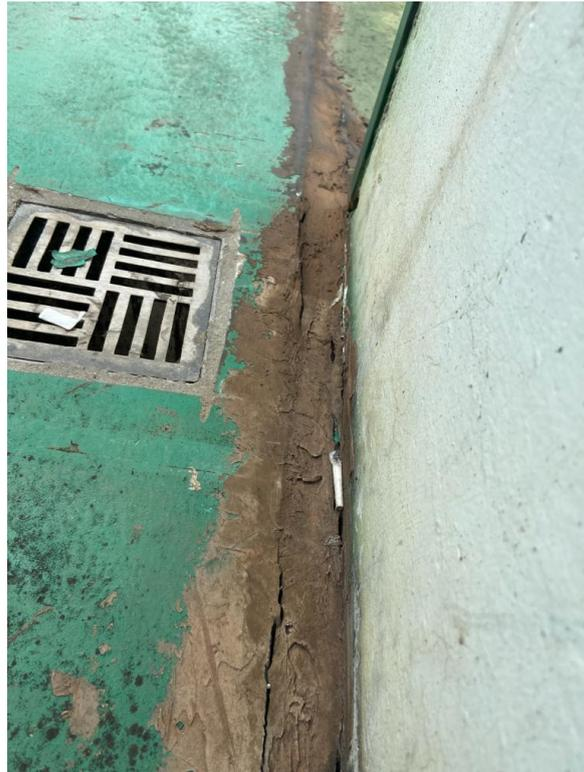
Fotos 6, 7, 8 e 9 – Juntas de Dilatação estão com desgaste excessivo.
