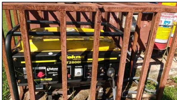
Gerador de emergência para alimentar luminárias de emergência
