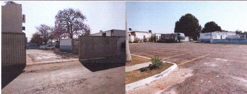
entrada de veículos
