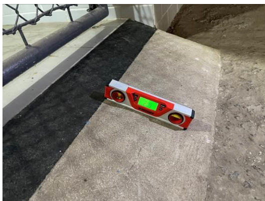
Detalhe dos desníveis e rampas fora de conformidade técnica
