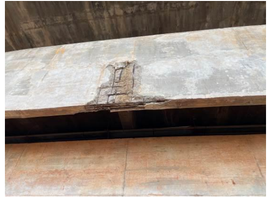
Detalhe de dano isolado em pilar e em viga externa
