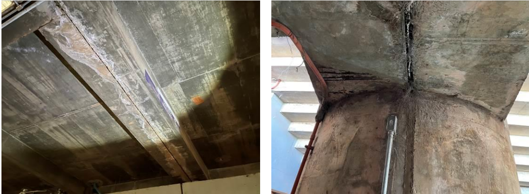
Detalhe da condição típica das juntas estruturais
