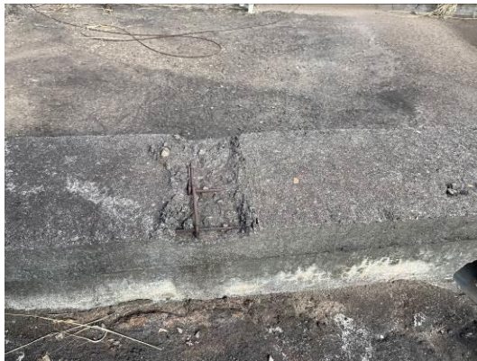
Detalhe de dano típico em vigas e juntas de dilatação
