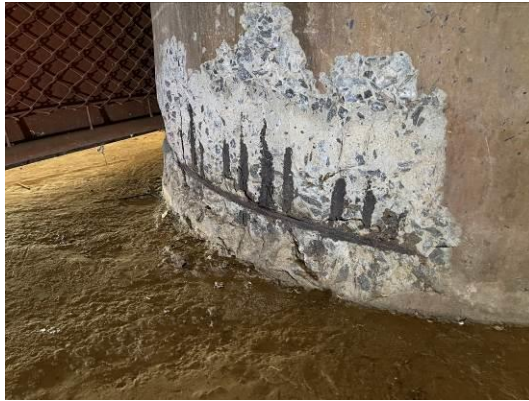
Detalhe de dano isolado em pilar e em viga externa
