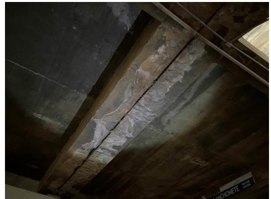
Detalhe de dano típico em vigas e juntas de dilatação
