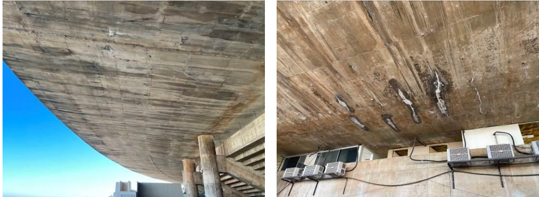
Vista da condição típica das coberturas
