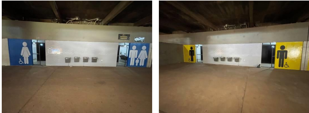
Vista do acesso aos banheiros
