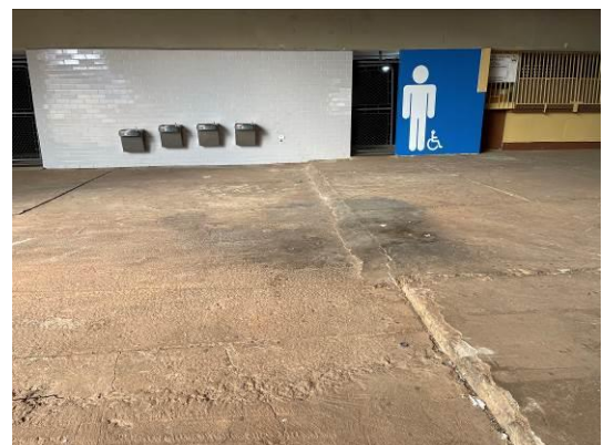
Detalhe dos desníveis e rampas fora de conformidade técnica
