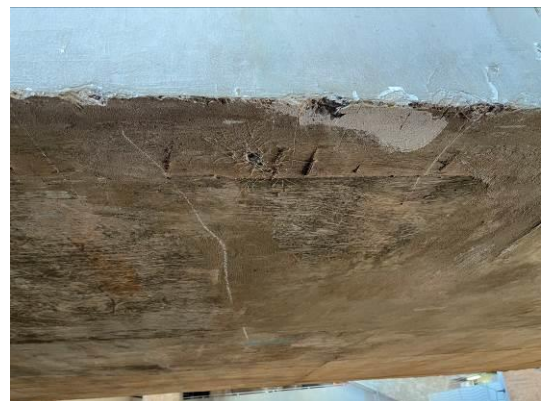
Detalhe de dano típico em vigas e fundo de lajes
