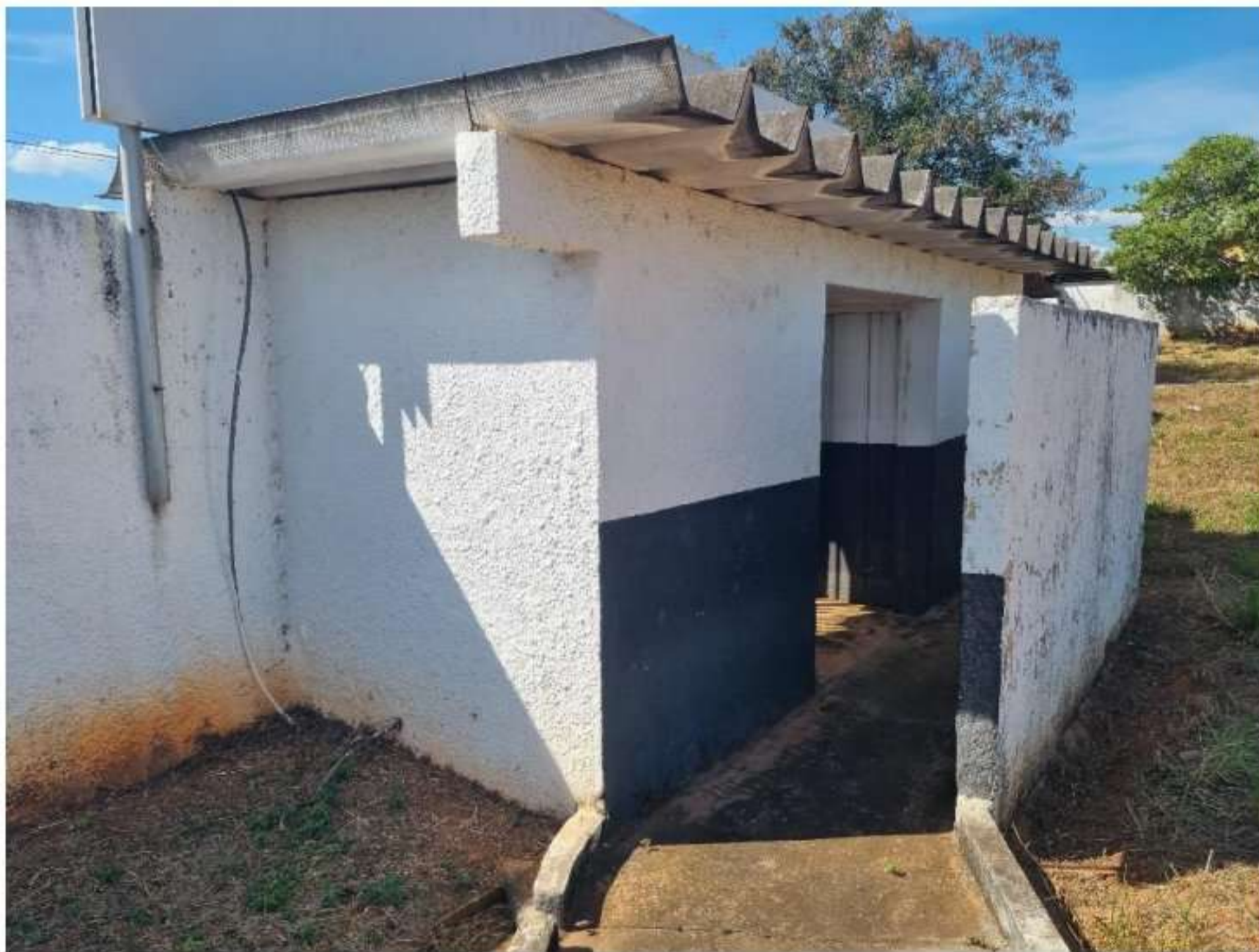
Foto 13: Bilheteria com cobertura em kaltheta
