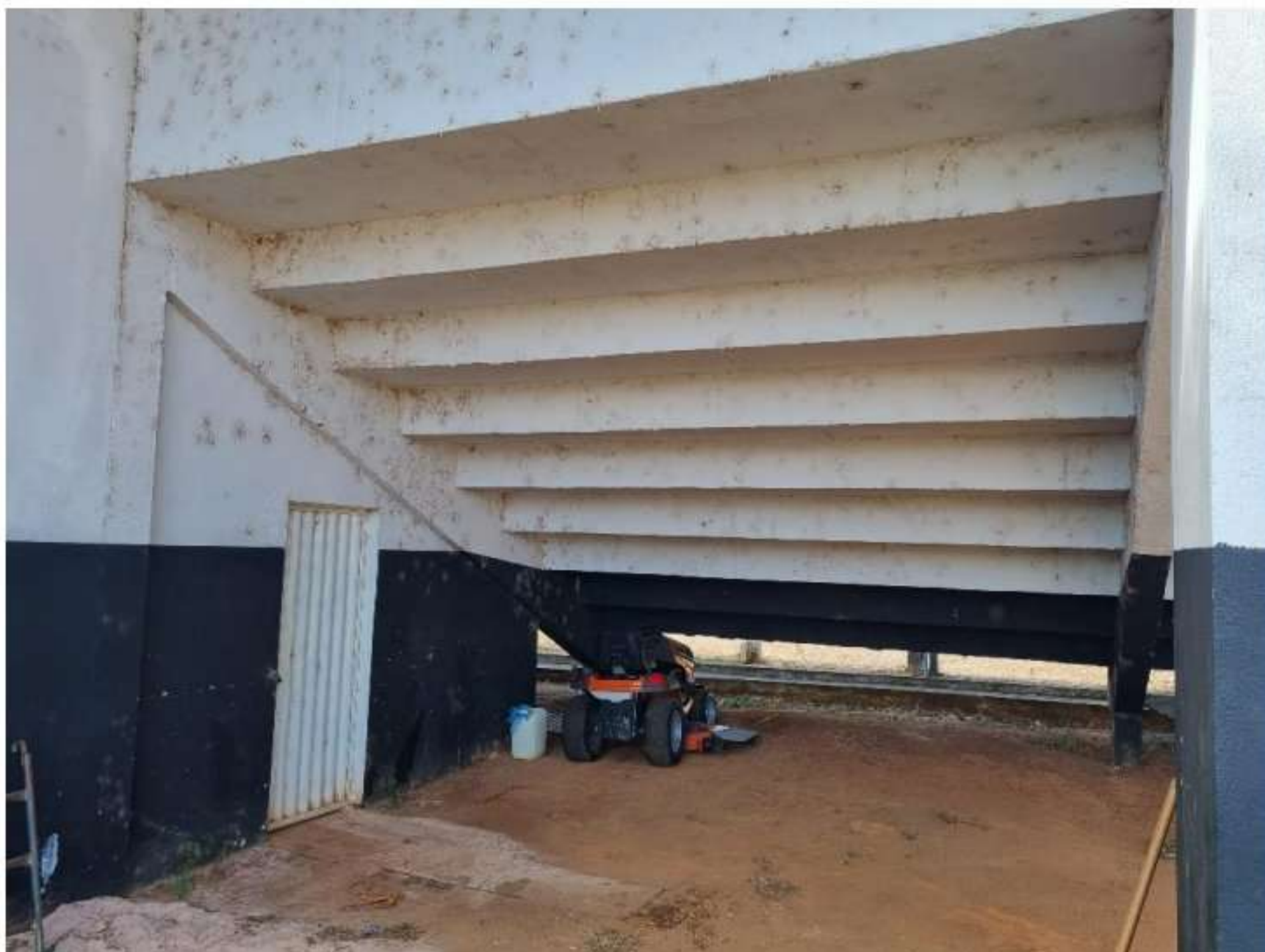
Foto 3: Parte posterior da Arquibancada I (estrutura sem fissuras aparentes)
