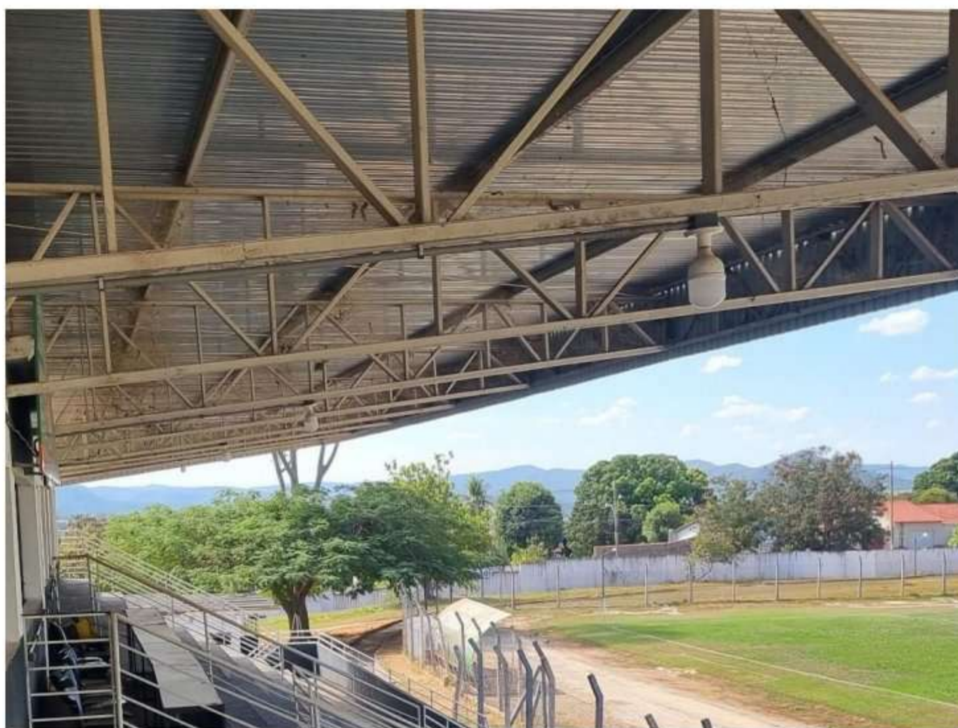
Foto 28: Iluminação da arquibancada
