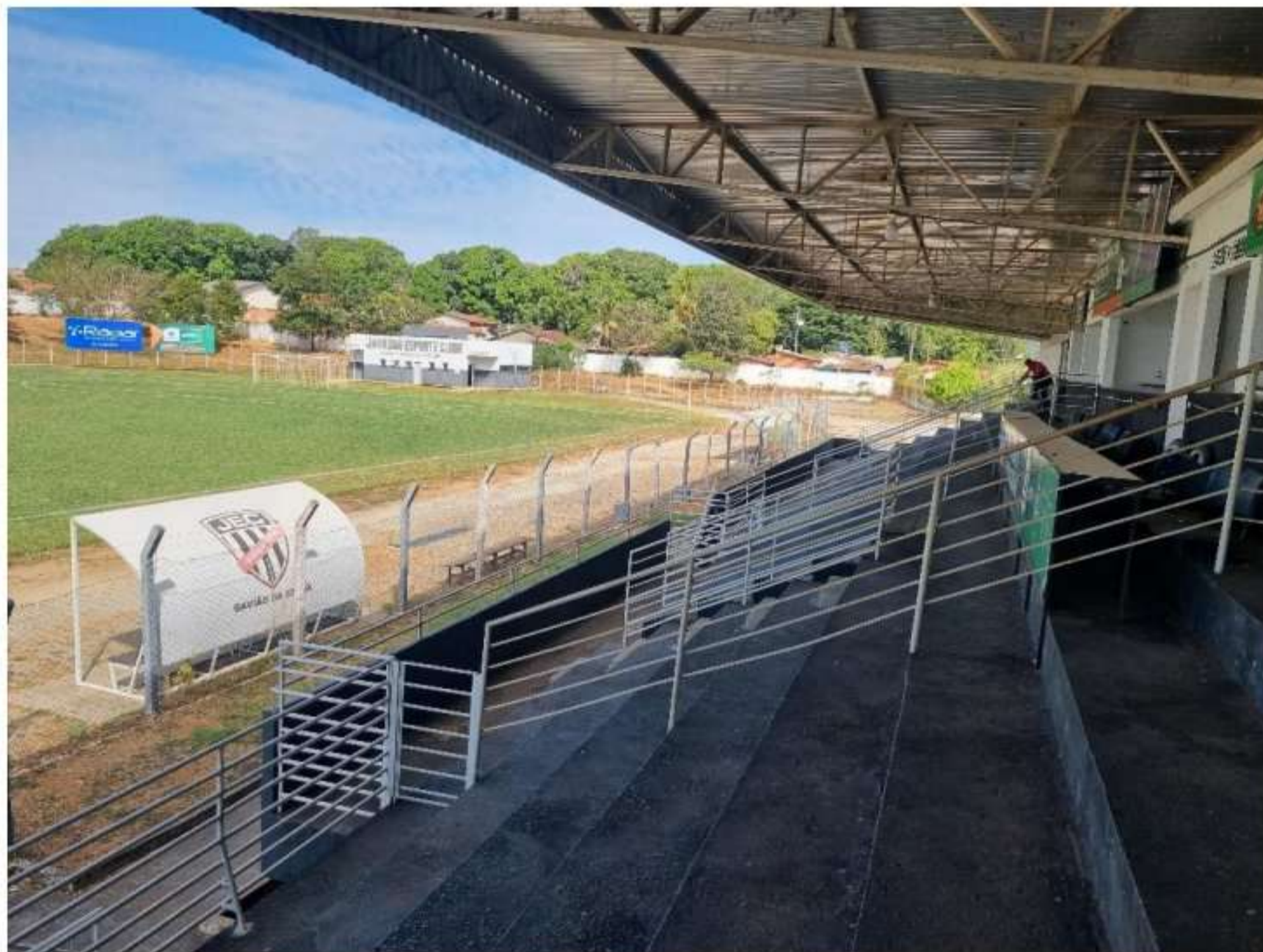
Foto 18: Corrimão e guarda corpo metálico
