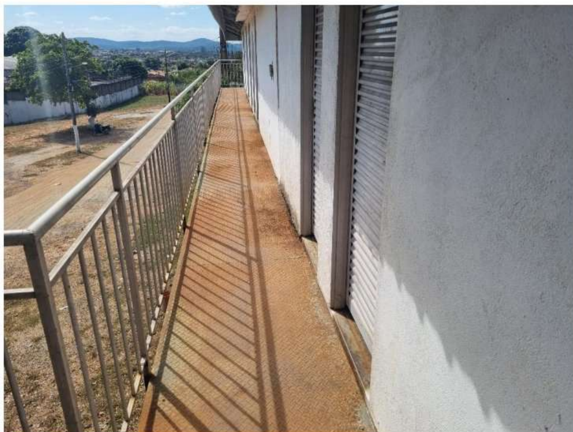
Foto 7: Cabines de rádio portas metálicas
