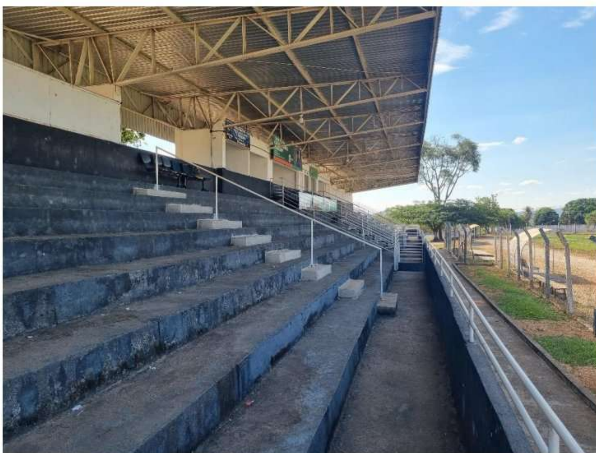
Foto 4: Arquibancada I (Estrutura metálica sem corrosão, flambagem ou danos aparentes)
