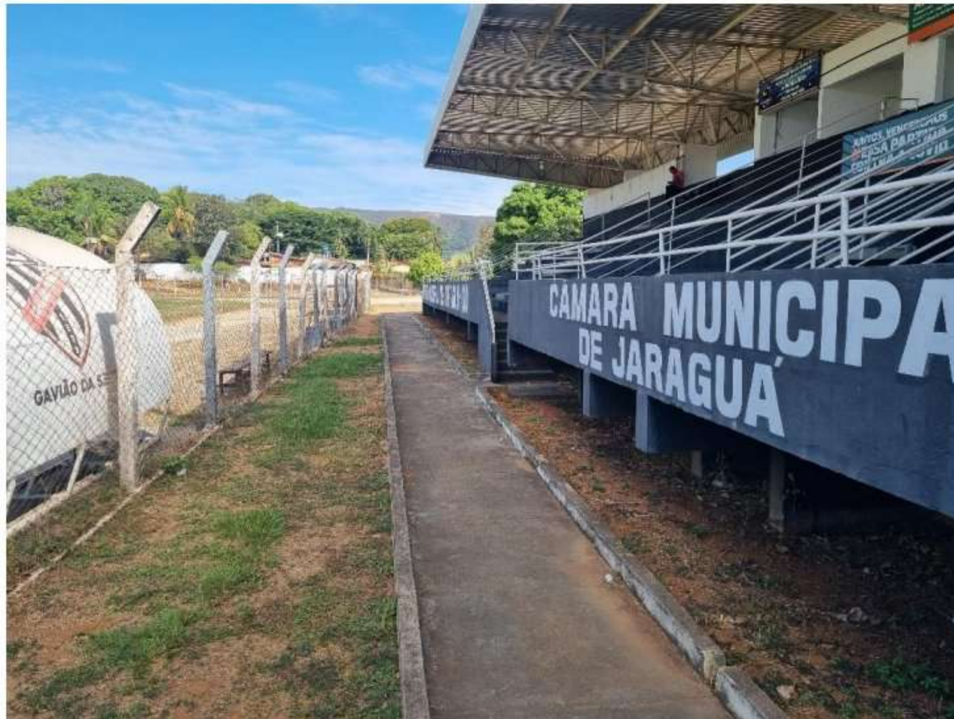
Foto 16: Acesso à arquibancada
