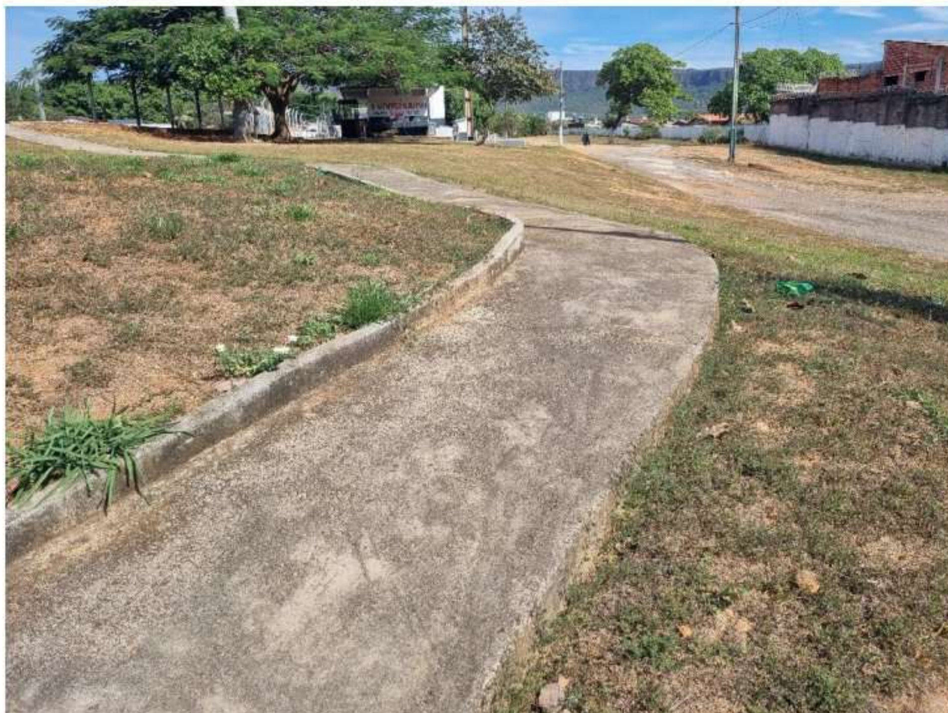
Foto 28: Rampa de acesso
