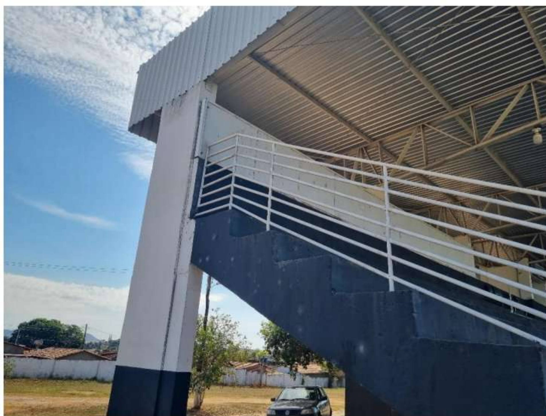
Foto 2: Parte lateral da Arquibancada I (pilar de sustentação da cobertura)
