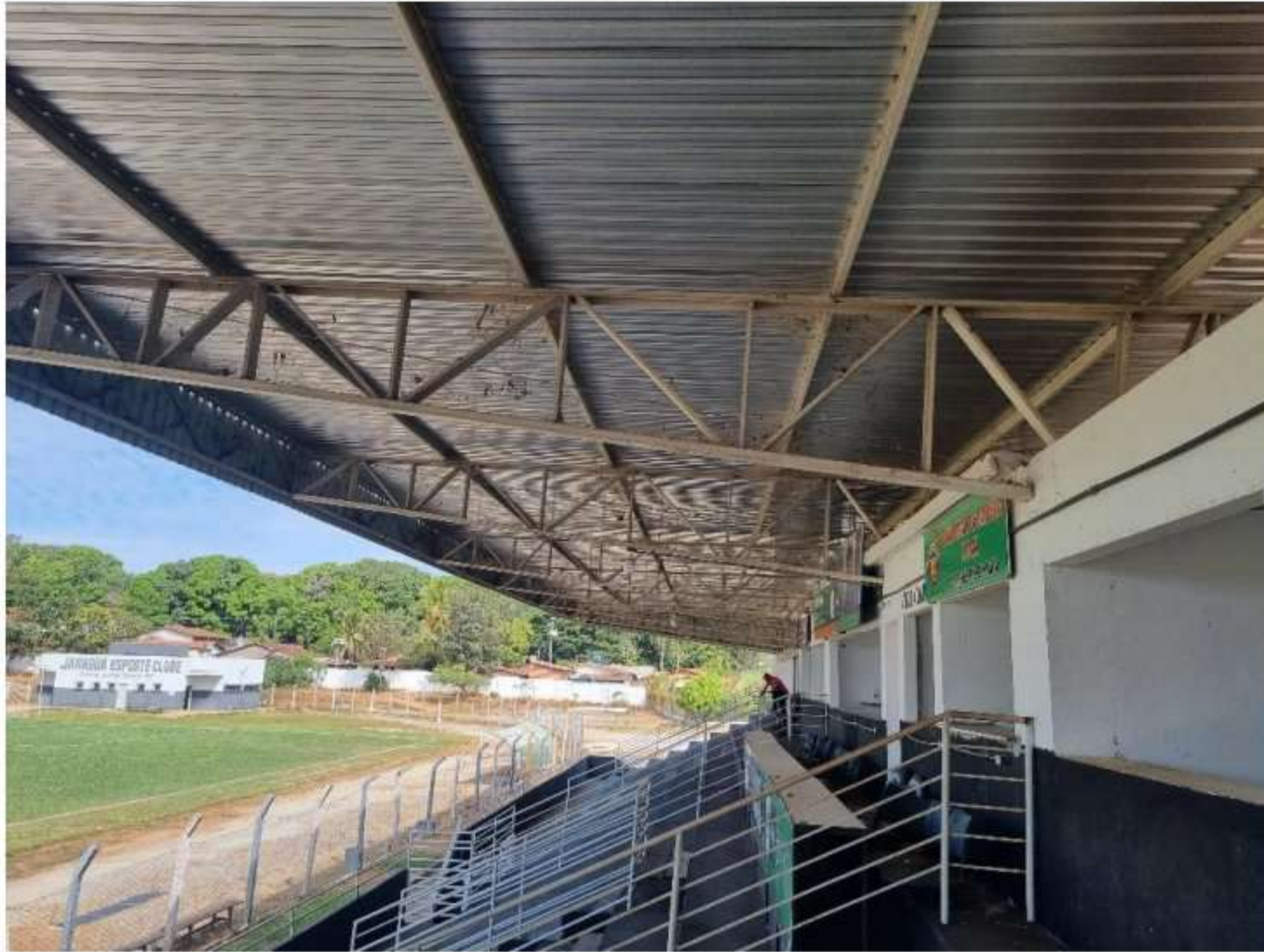
Foto 14: cobertura da arquibancada
