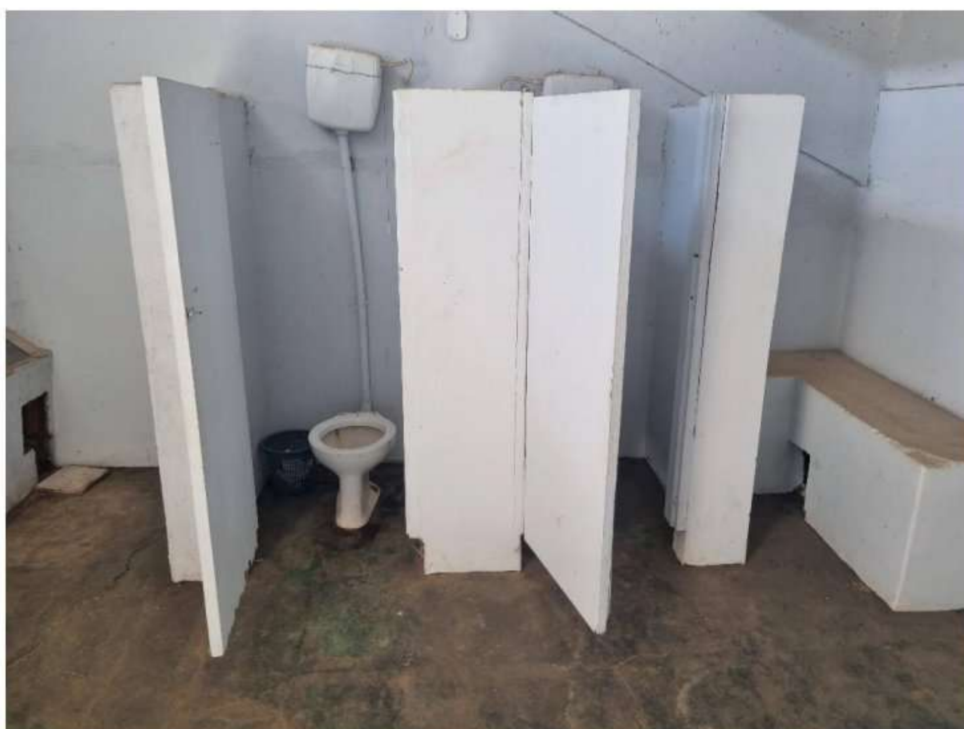
Foto 23: Divisórias nos banheiros
