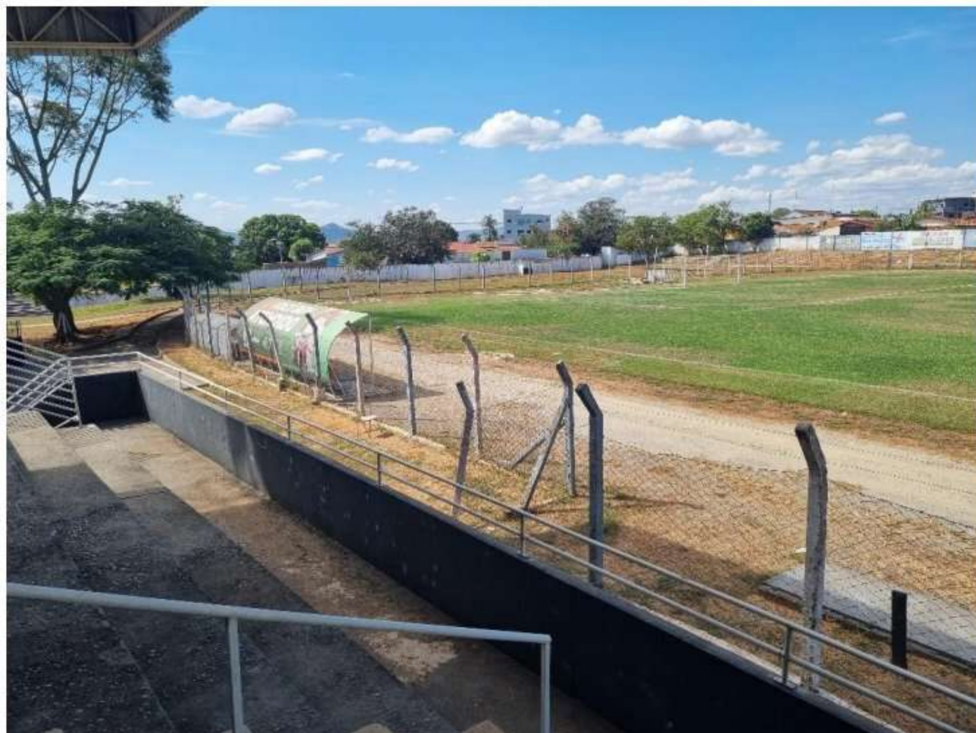
Foto 9: Alambrados em boas condições
