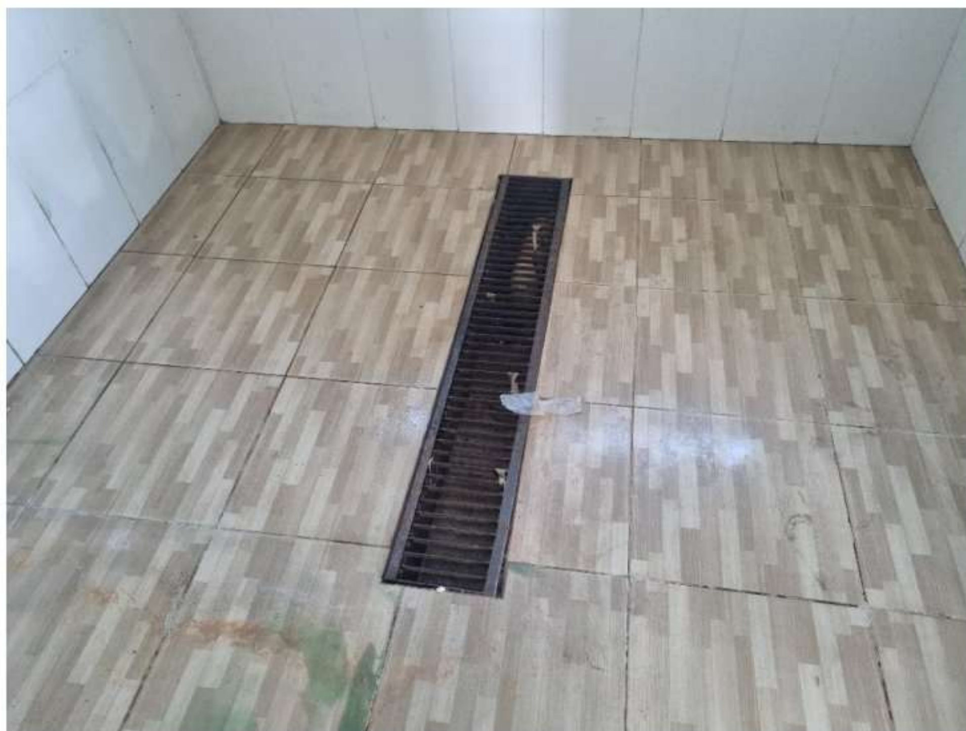
Foto 16: Revestimento cerâmico dos vestiários
