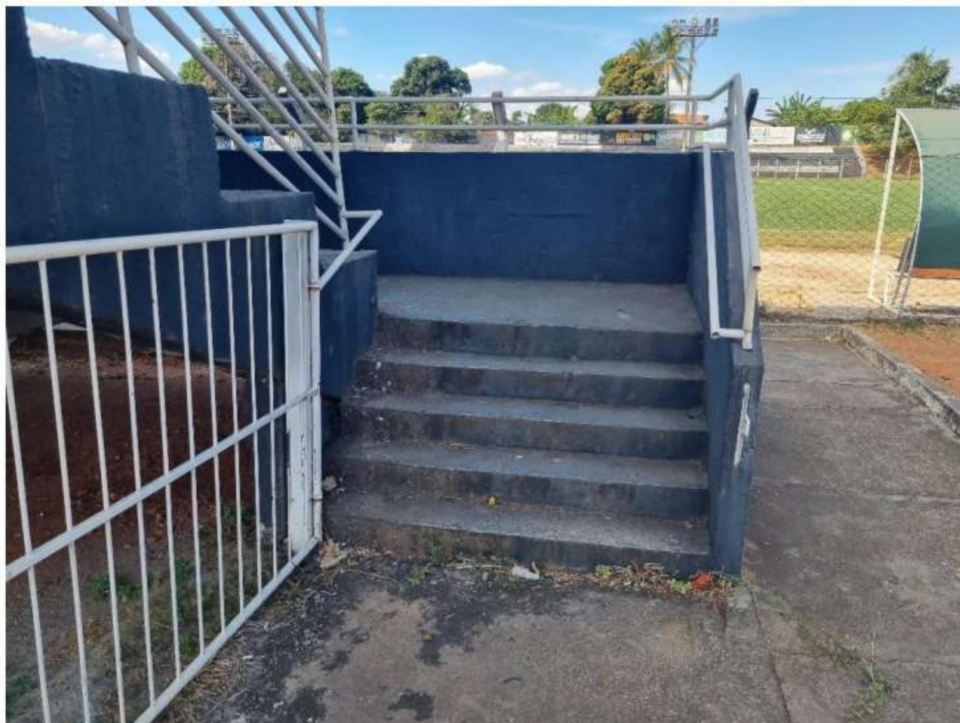
Foto 19: Escada de acesso a arquibancada
