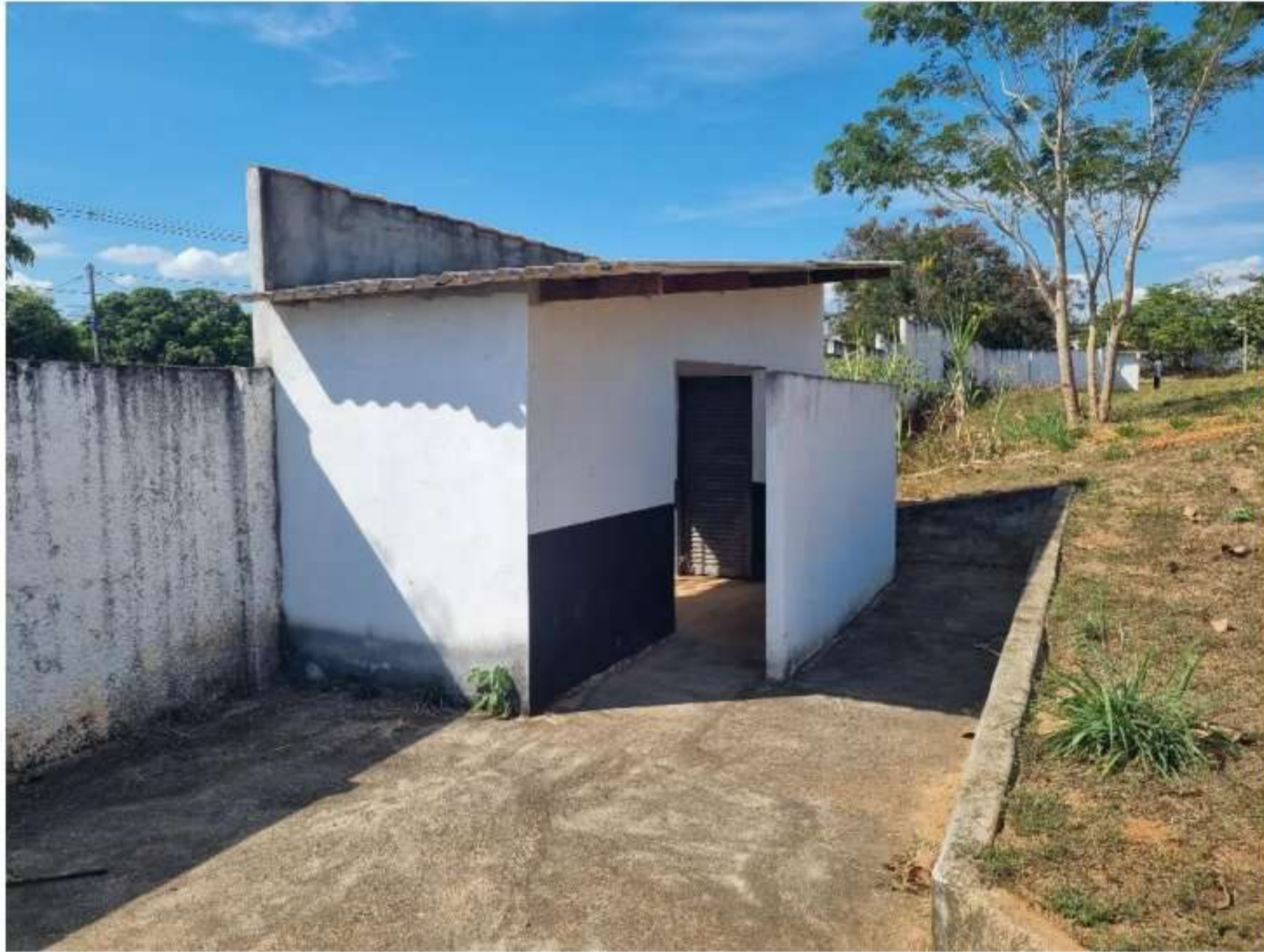
Foto 12: Bilheteria com cobertura em fibrocimento
