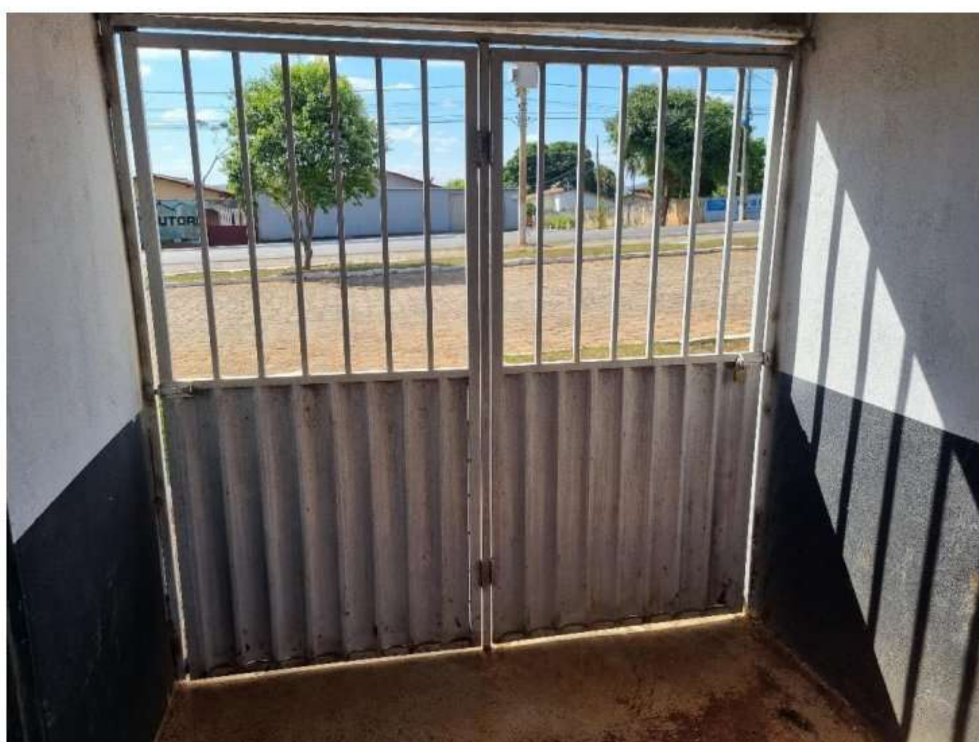
Foto 8: Bilheteria portão de acesso
