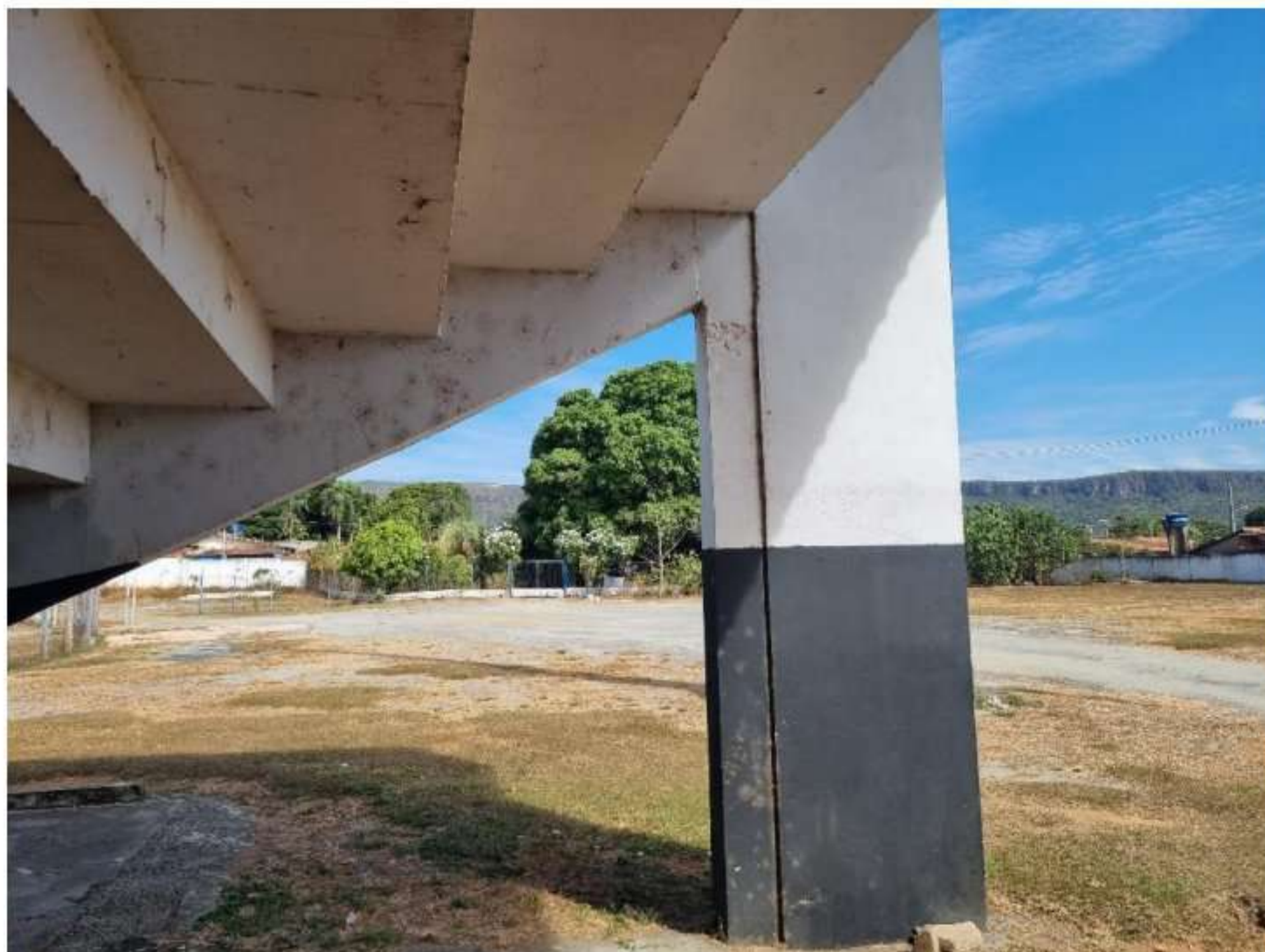
Foto 1: Parte posterior da Arquibancada I (pilar de sustentação)
