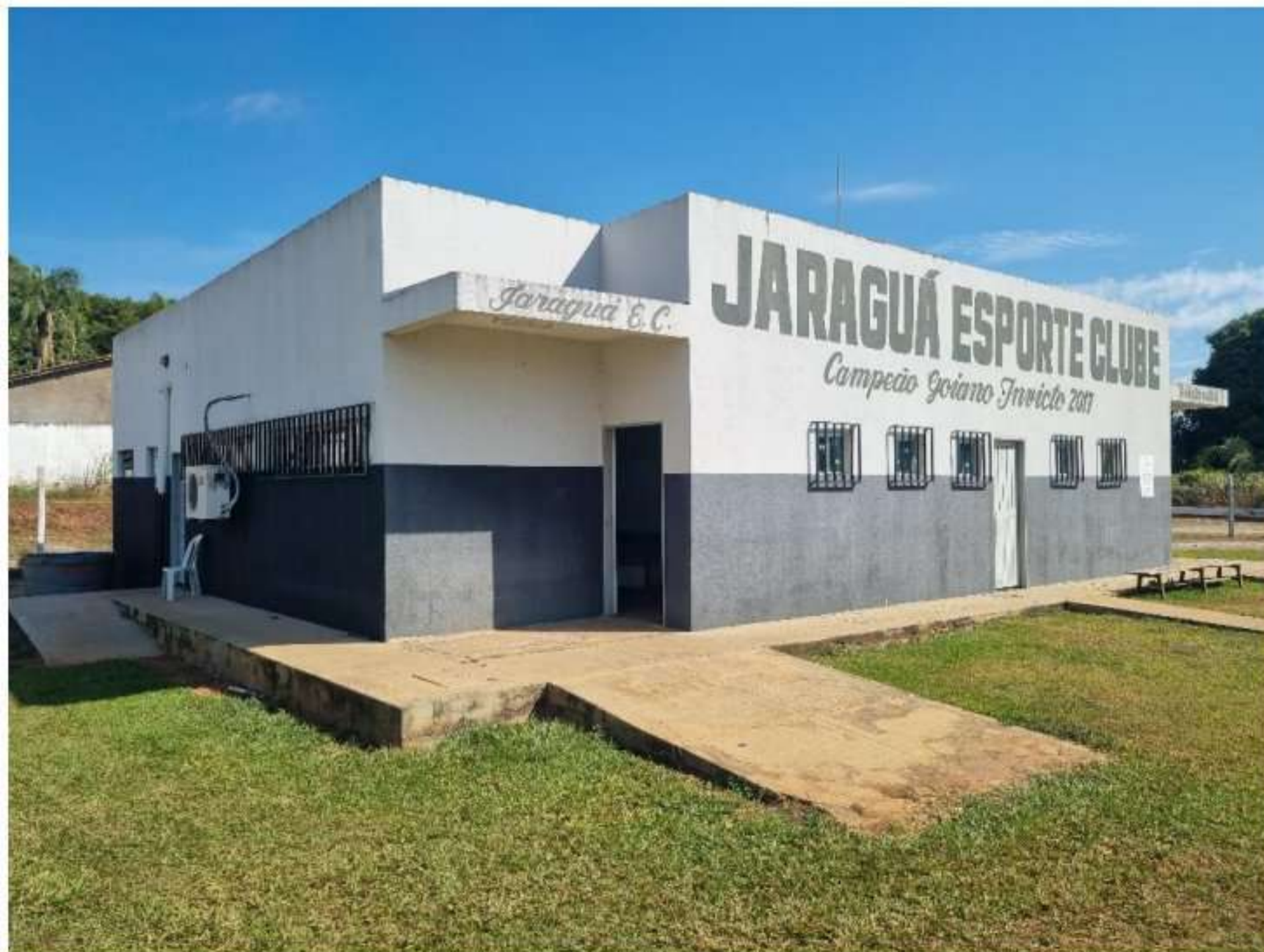
Foto 5: Vista externa do vestiário
