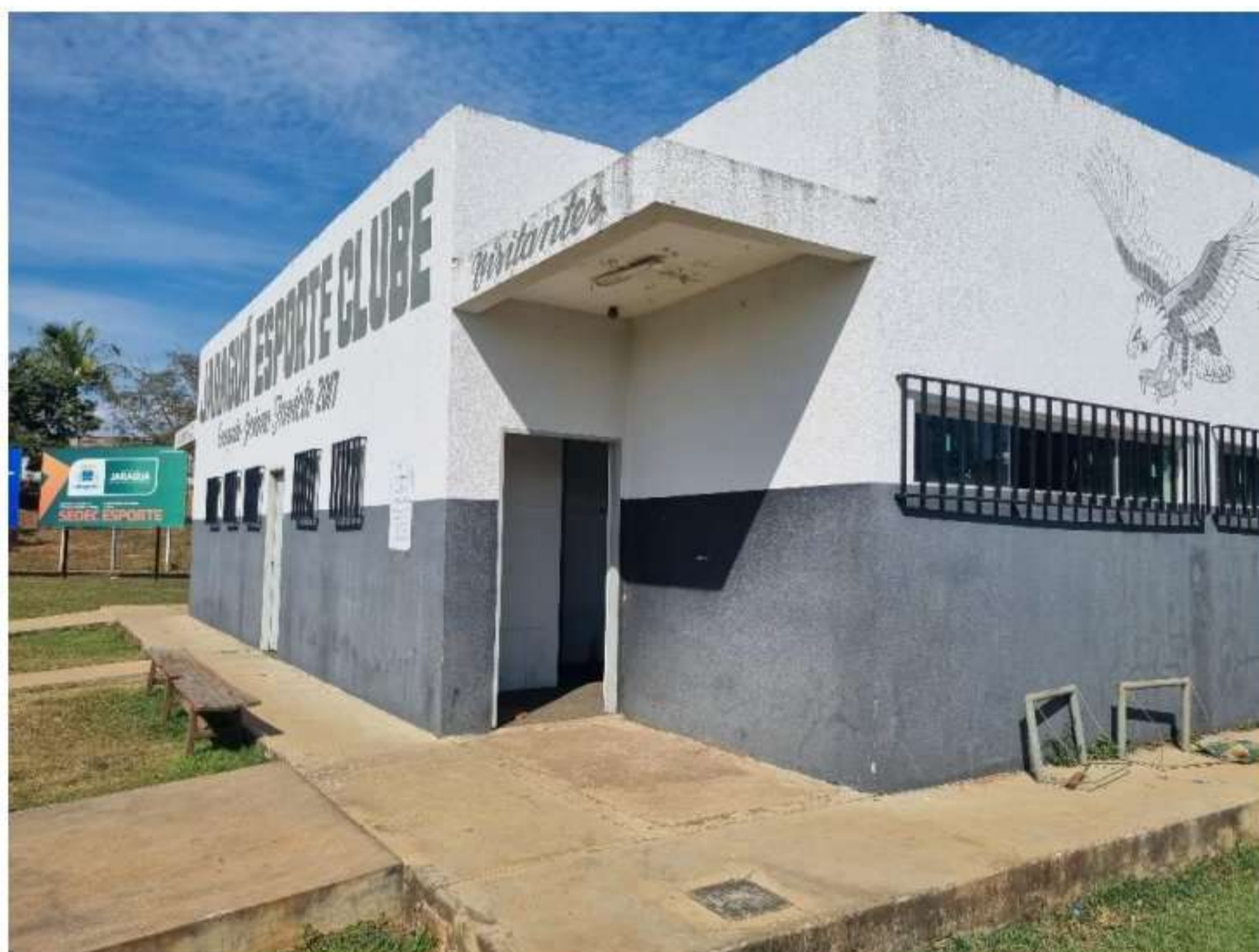
FOTO: Sistema de Revestimento
