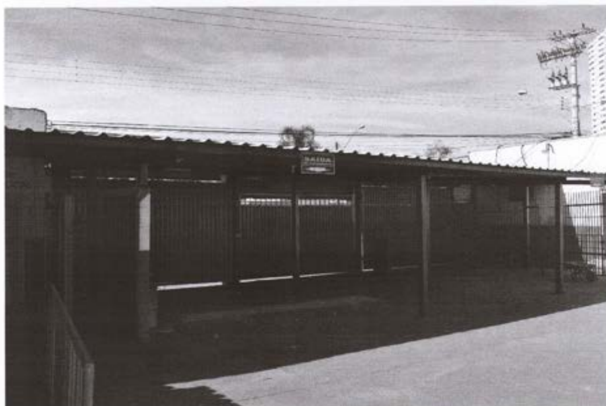
PORTÕES DE ACESSO – VISTA INTERNA
