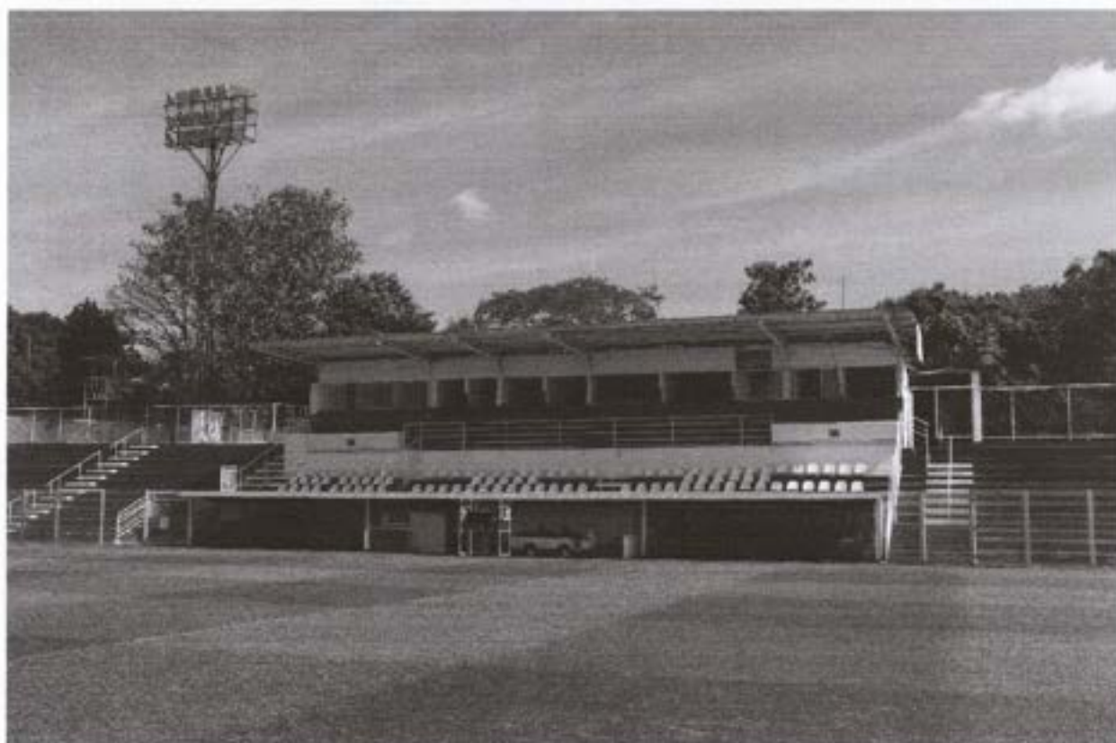
VISTA CABINES E LATERAL OESTE
