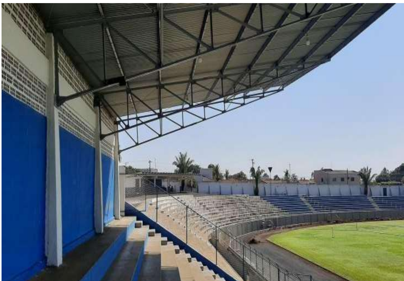
Figura 15 - Arquibancada principal a qual possui cobertura em estrutura metálica e telha de zinco
