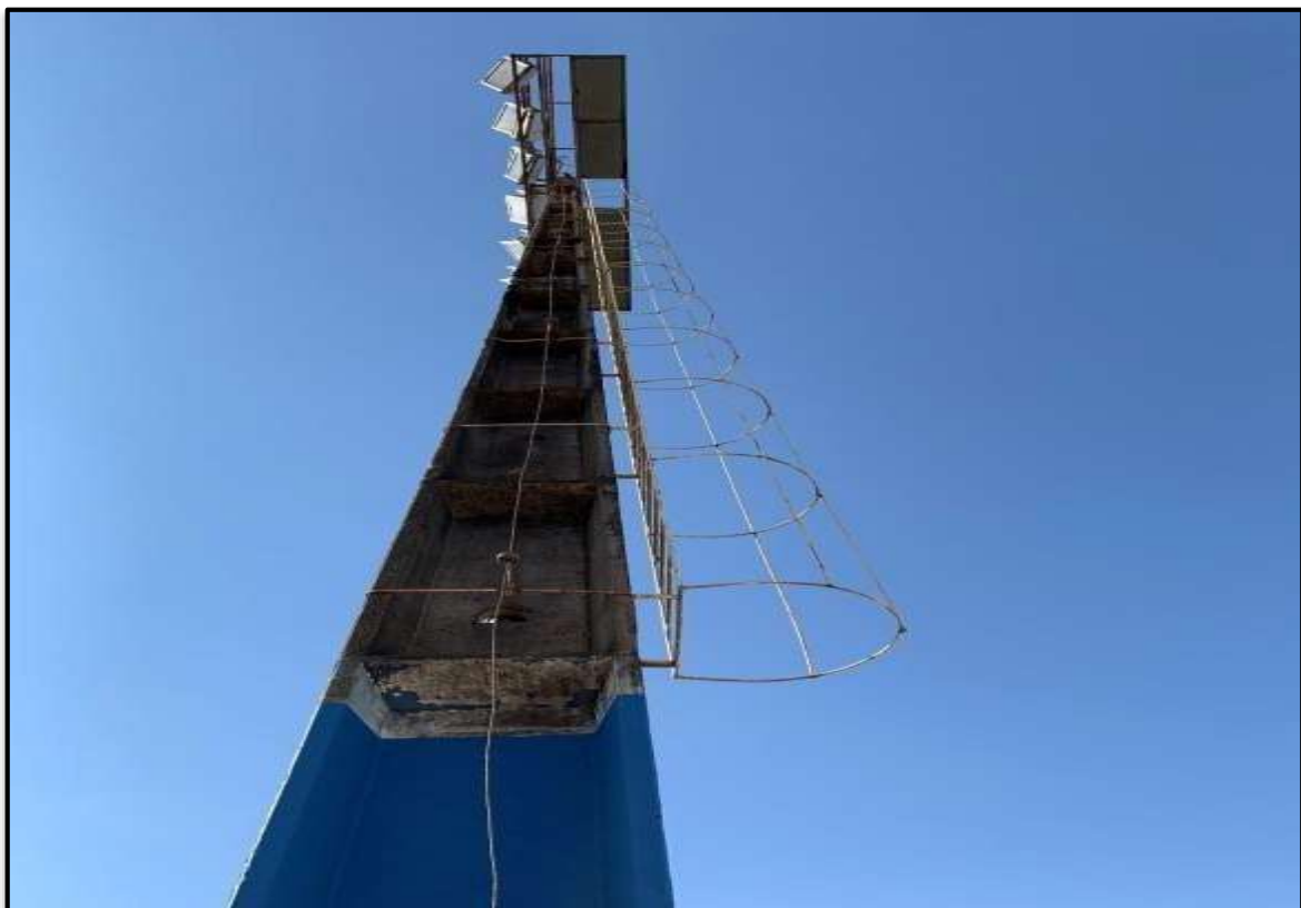
Figura 29 - Todos os postes dos refletores possuem parte do sistema SPDA
