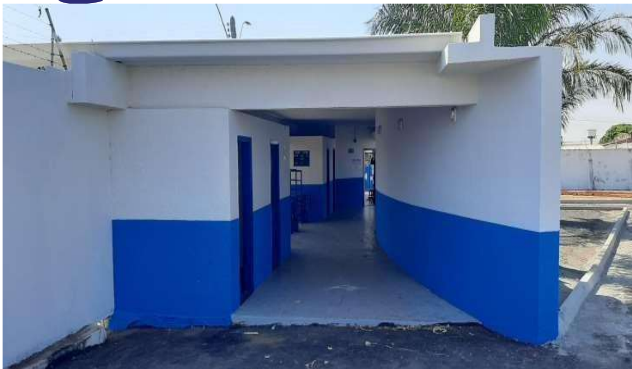
FIGURA 19 – Cobertura de telha zincada apoiada em viga e pilar de concreto
