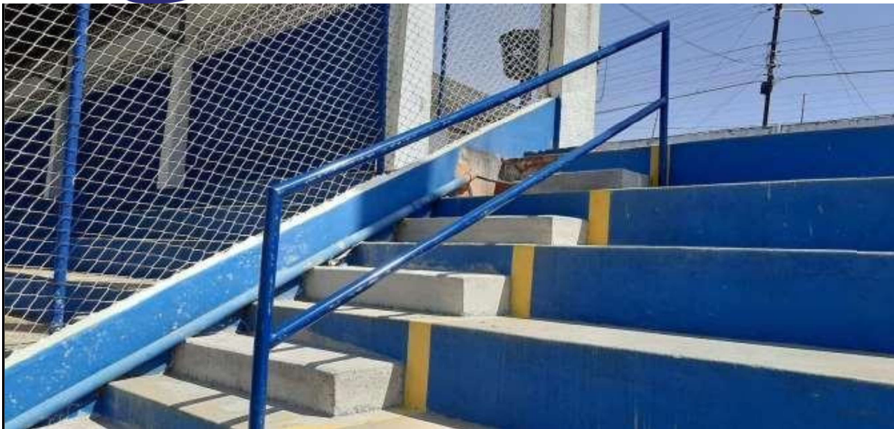
Figura 5 – Guarda-corpo e escadas de emergência a cada 20 metros, nas dimensões de 16cm altura x 120cm largura x 36cm de comprimento
