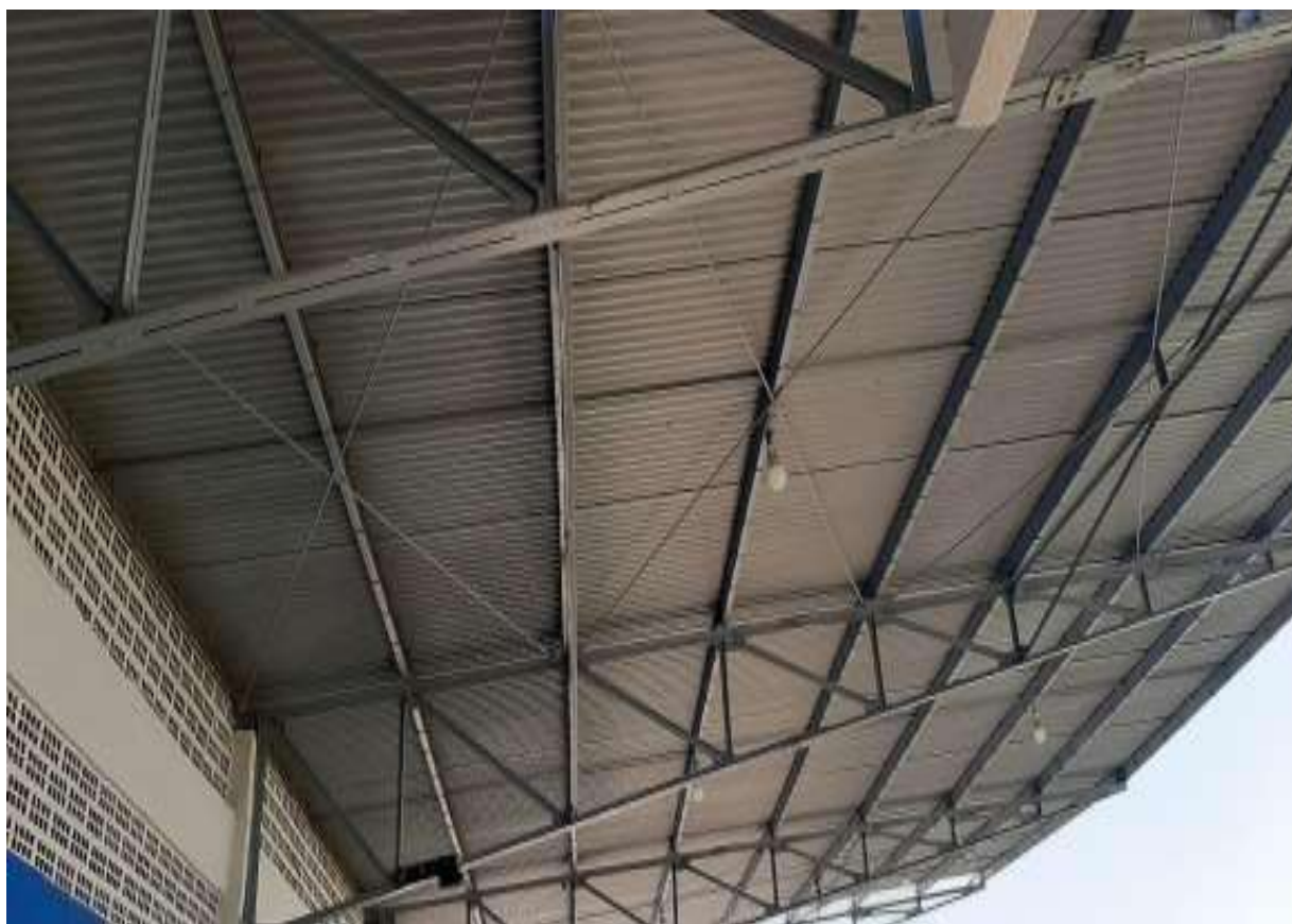
Figura 18 - Cobertura em estrutura metálica com telha zinco em boas condições engastada nos pilares de concreto armado
