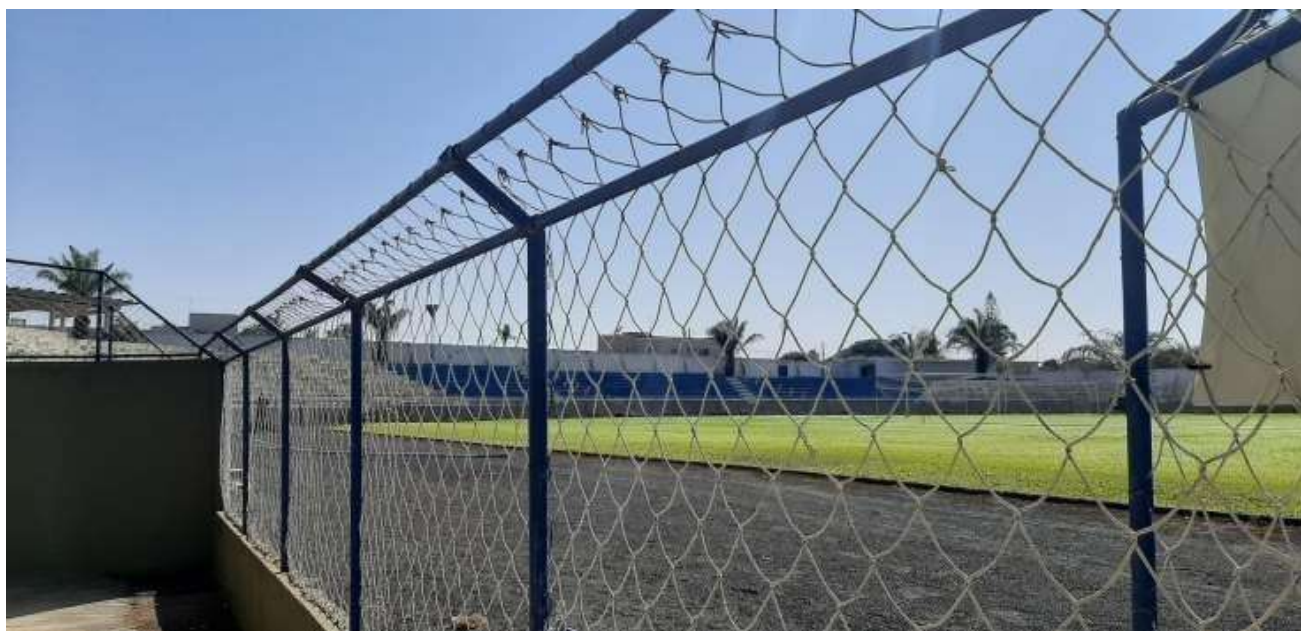
Figura 4 - Campo cercado com estrutura metálica tubular e tela de proteção
