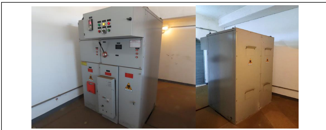
FOTO 55: CUBÍCULO DE PROTEÇÃO PRINCIPAL
