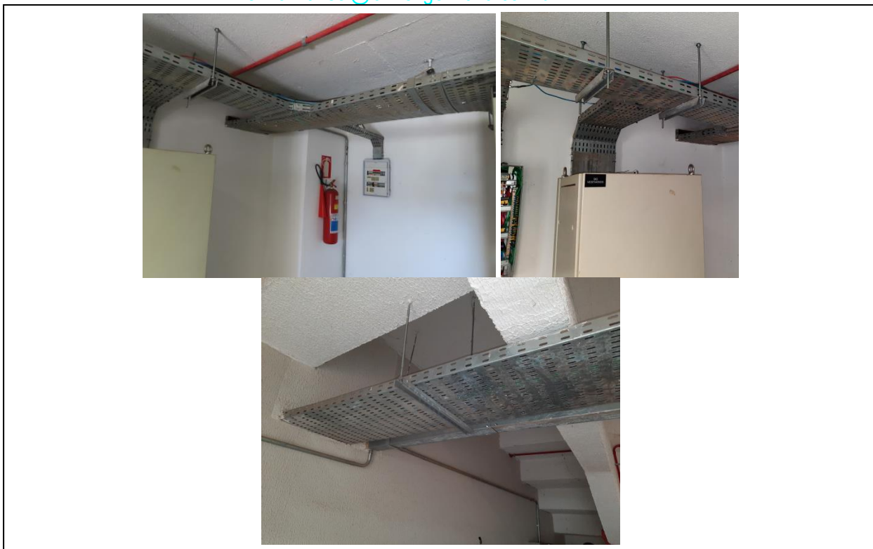
FOTOS 70 a 72: ELETROCALHAS E FIXADORES EM BOAS CONDIÇÕES
