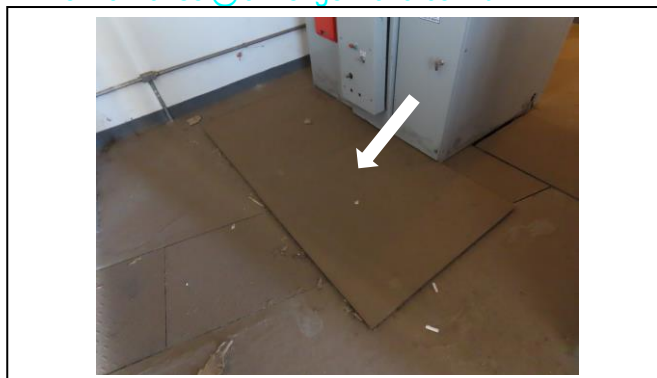
FOTO 56: MANTA DE ISOLAÇÃO
