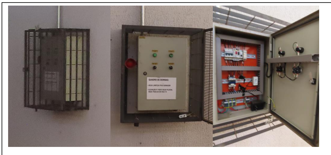
FOTOS 83 a 85: COMANDO DA BOMBA DE IRRIGAÇÃO
